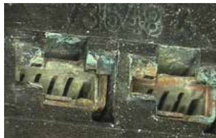
Kupplung mit Feuchtigkeit und Korrosionsspuren
