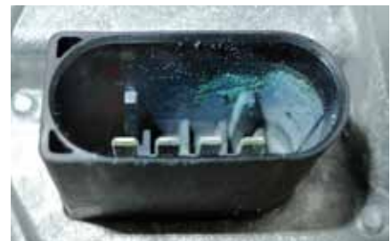
Einbaustecker mit Korrosionsspuren
